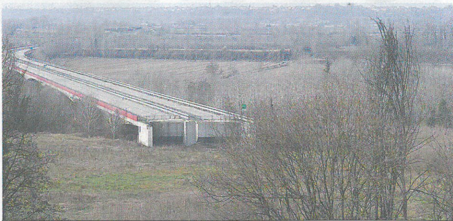
L'autostrada Cuneo-Asti è ferma a un punto morto
